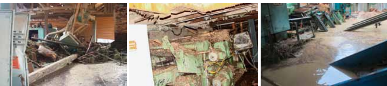
Die Überschwemmung hat die gesamte Sägerei komplett verwüstet.
